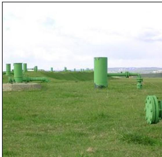
*Figura 3. Chimeneas de extracción de biogás*
