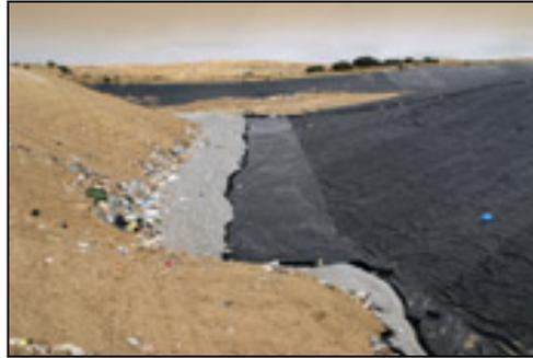
Figura 5. Impermeabilización de un vertedero de RSU
